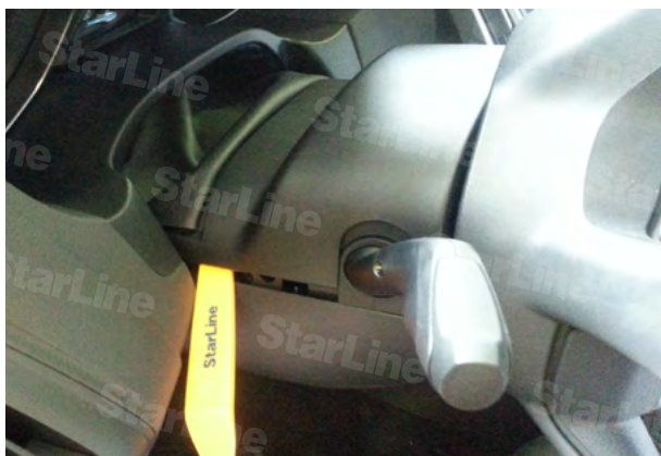
Фото 2.1. Снять верхнюю часть кожуха
