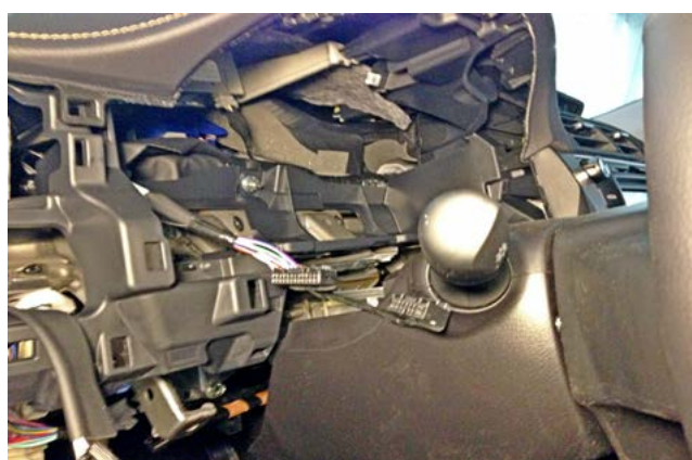
Фото 1.20. Панель приборов снята
